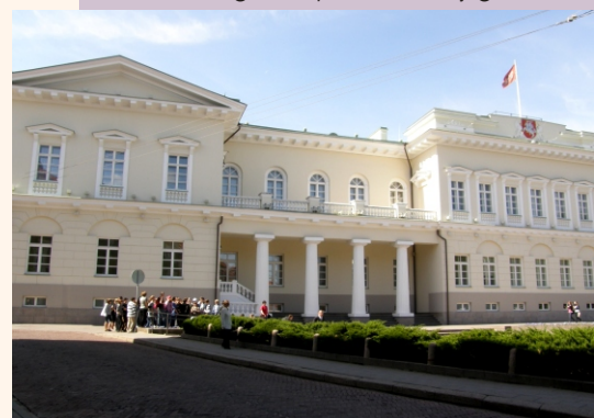
Prezidentūros šiaurinis fasadas S. Daukanto a. 3
