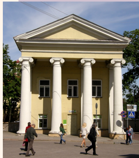
Šuazelių-De Reusų rūmai S. Daukanto a. 2
