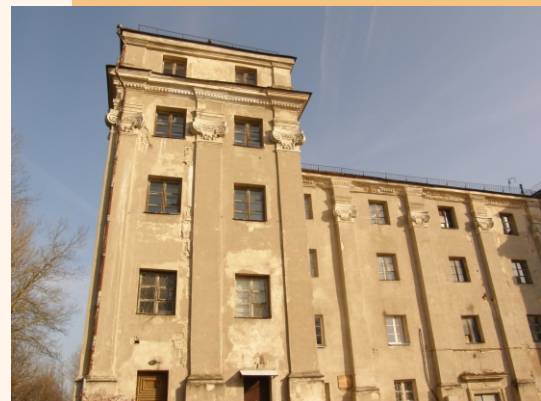
Slušų rūmų šoninis fasadas T. Kosčiuškos g. 10
