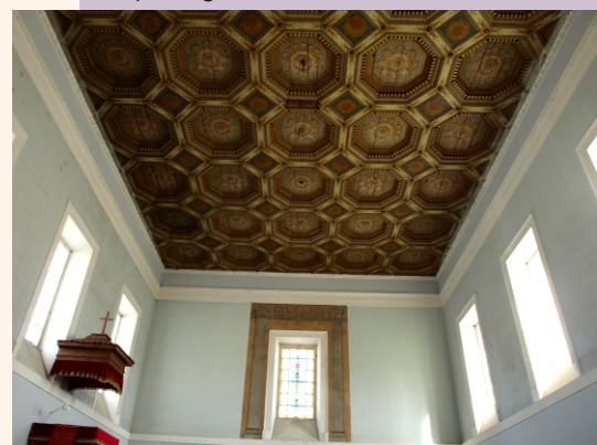
Evangelikų reformatų bažnyčios lubos, Pylimo g. 18
