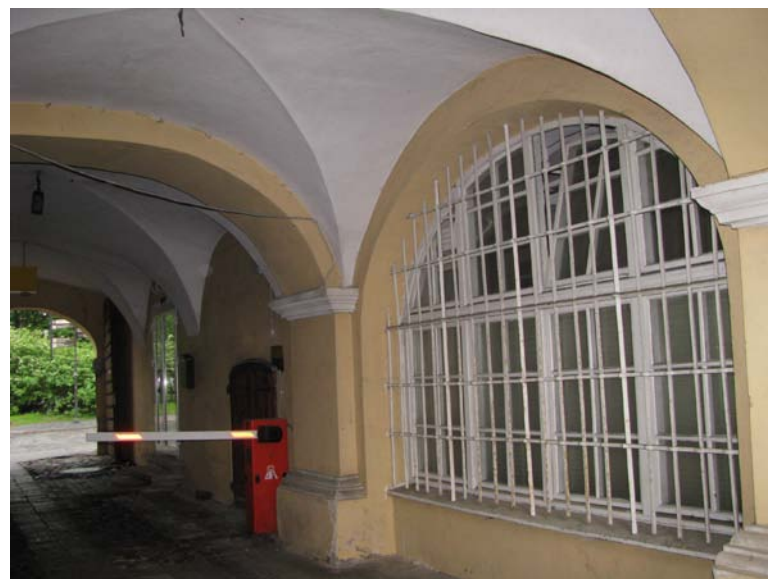
Vaizdas tarpuvartėje ties patalpa 1-18
