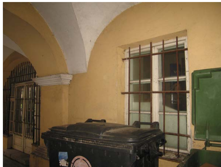
Vaizdas tarpuvartėje ties patalpa 1-4
