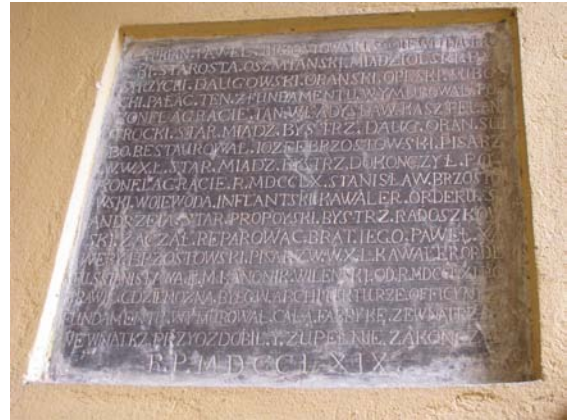
Istorinė lenta rūmų V fasade ties įėjimu į patalpą 1-11
