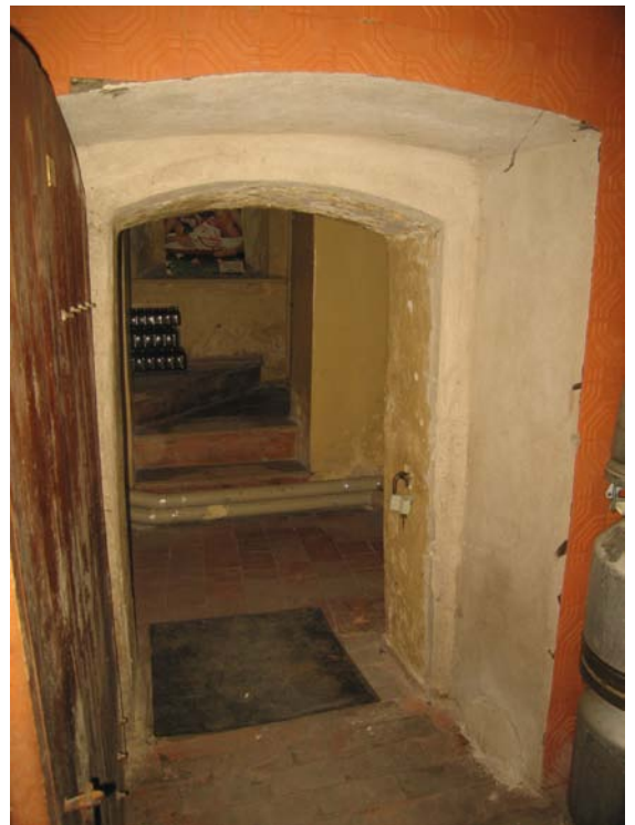
Vaizdas iš patalpos R-13 į patalpą R-8
