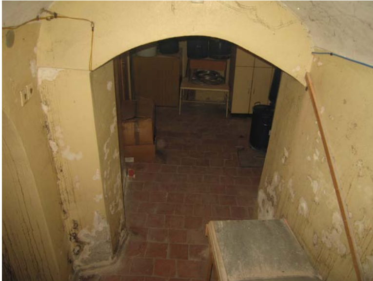
Vaizdas iš patalpos R-7 į patalpą R-4
