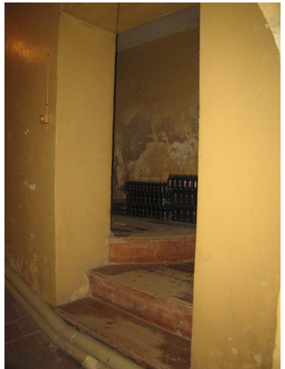
Vaizdas iš patalpos R-8 į patalpą R-14
