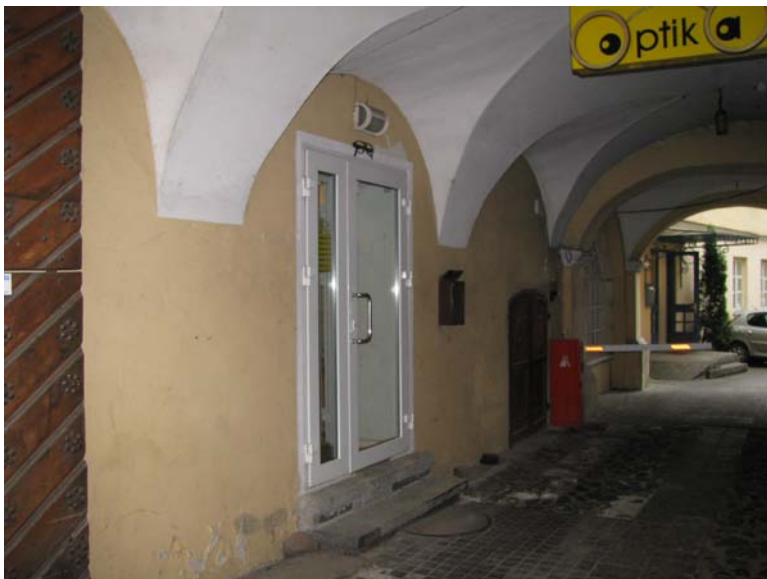
Vaizdas tarpuvartėje ties patalpa 1-19
