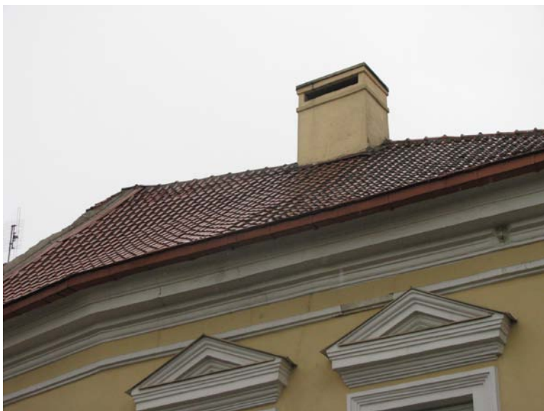
Universiteto g. fasado ir stogo fragmentas ties 2-ro a. patalpa 2-18
