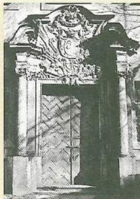
Šv. Trejybės bažnyčios portalas. H. Vičas.
