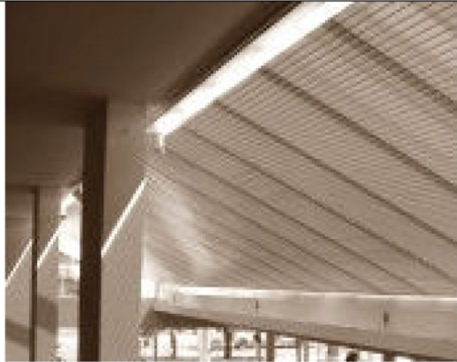
Apsauginės žaliuzės. Rekomenduojama spalva – keraminių čerpių. Gali būti montuojamos įvairiais kampais.
