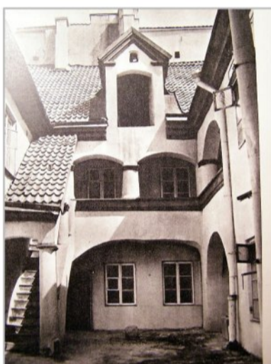
Pilies g. 32 kiemas Stoglangis, skirtas prekių įkėlimui
