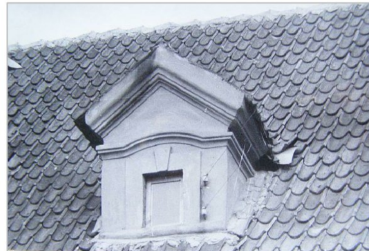
Didžioji g. 27 Stoglangis, skirtas pastogės vėdinimui ir apšvietimui
